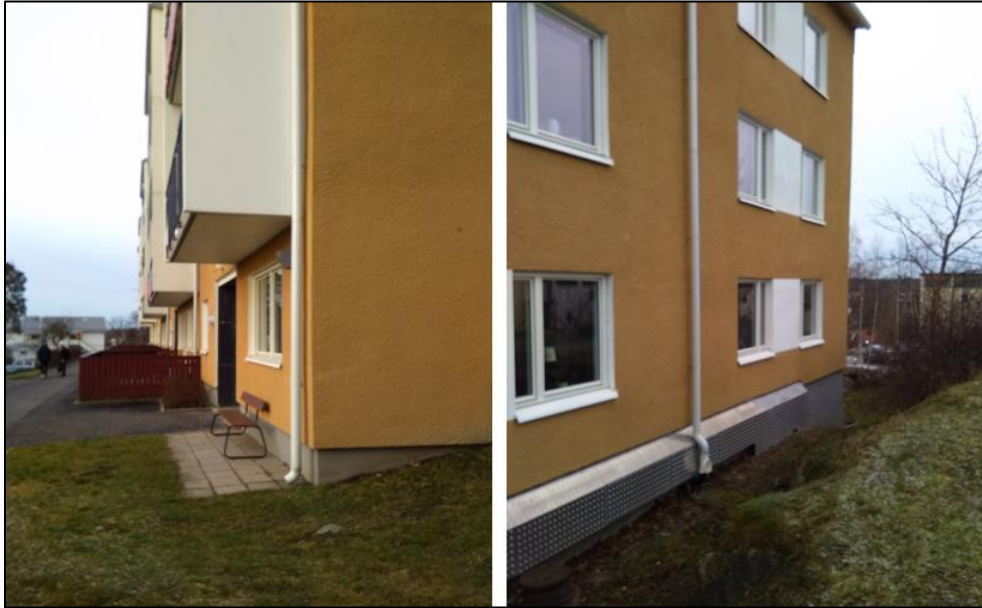
Figur 4. Stuprör med utkastare samt stuprör som leder ner till marken
