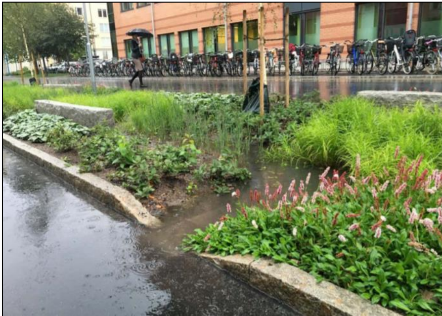
Figur 9. Exempel på växtbäddar, observera utformning av kantsten (Foto: Rasmus Elleby)
